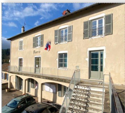
Mairie et 2 logements au dessus de la mairie
