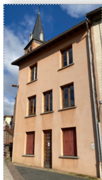
Maison de quartier
