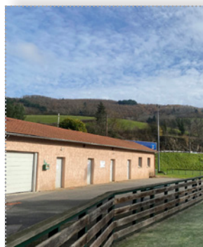
Les vestiaires du stade de football
